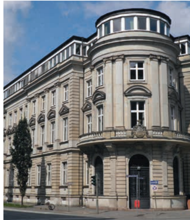
Das Stadthaus nach dem Wiederaufbau in der Nachkriegszeit, 2011 Foto: Herbert Diercks, Archiv der KZ-Gedenkstätte Neuengamme, Hamburg
