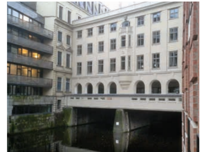
Rückseite Stadthausbrücke, Überbauung Bleichenfleet: Brückenarkade mit „Seufzergang“ Foto: Uwe Leps, 16.4.2018
